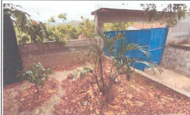
Foto 4: Puerta y ventana
