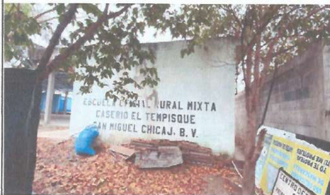
Foto 1: Reparación de repello y cernido de paredes.
