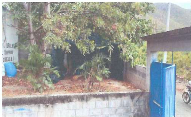
Foto 3: Cubierta de lamina
